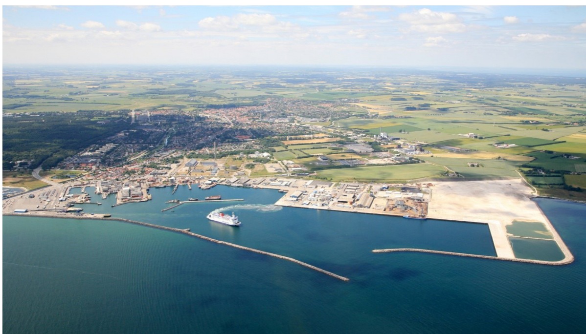
Grenaa District Heating 格雷诺区域供暖
