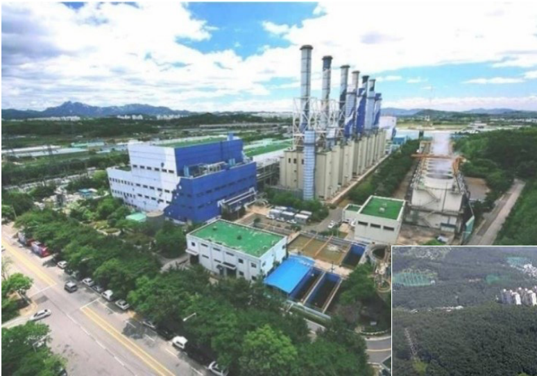
Ilsan Power Plant 韩电日山电厂
